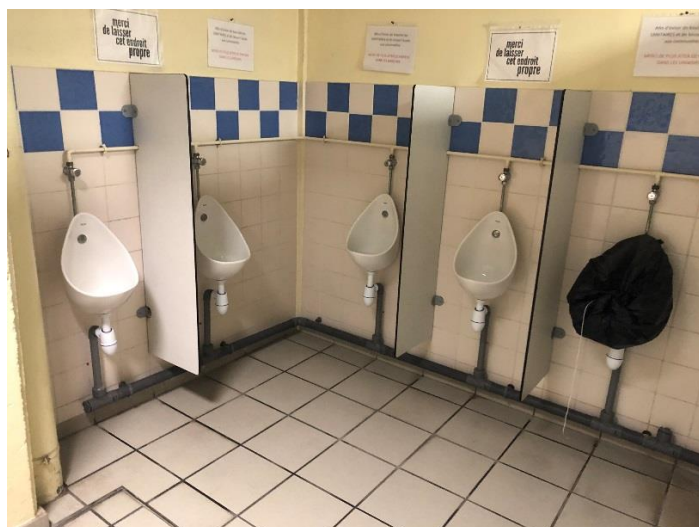
Cinq (5) urinoirs à effet d'eau raccordés à la FF
