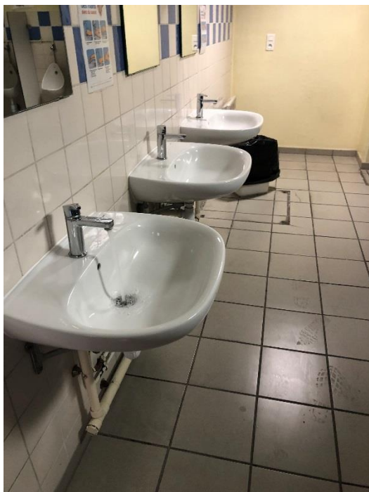
Trois lavabos raccordés sur le réseau Eaux pluviales
