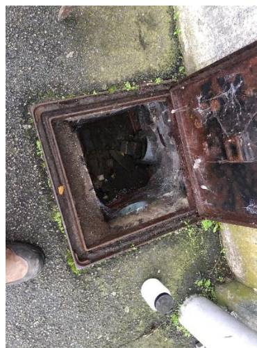
Regard de visite Eaux Pluviales Gouttière entrée sanitaires
