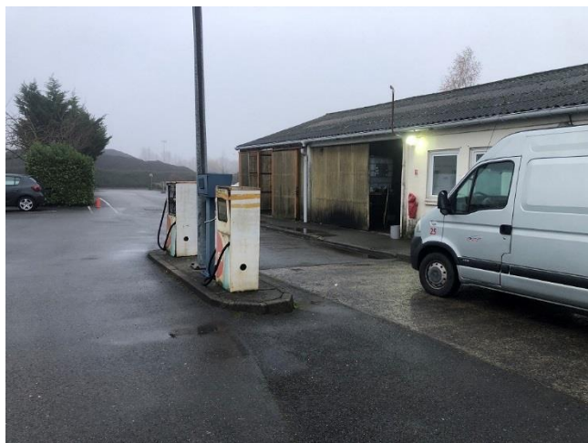
Vue dalle en béton sur cuve et une aération haute (dégazage)
