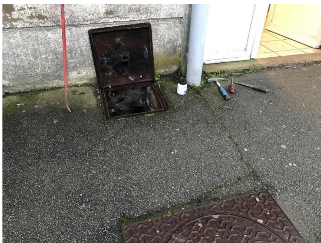
Regard de visite Eaux Pluviales Gouttière entrée sanitaires
