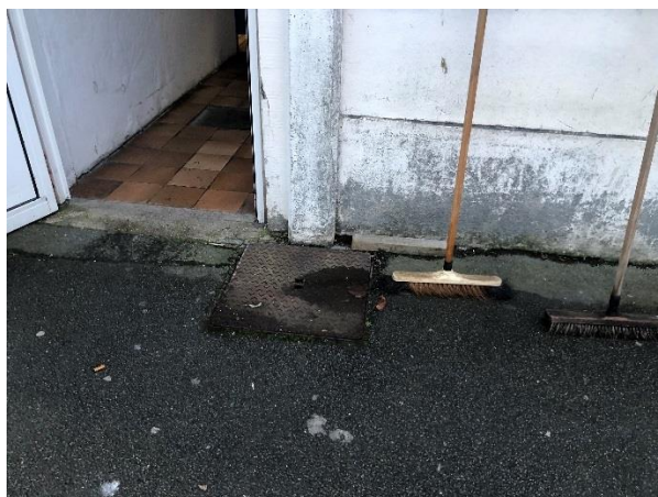
Regard eaux pluviales reprise rejet cuisine et gouttière
