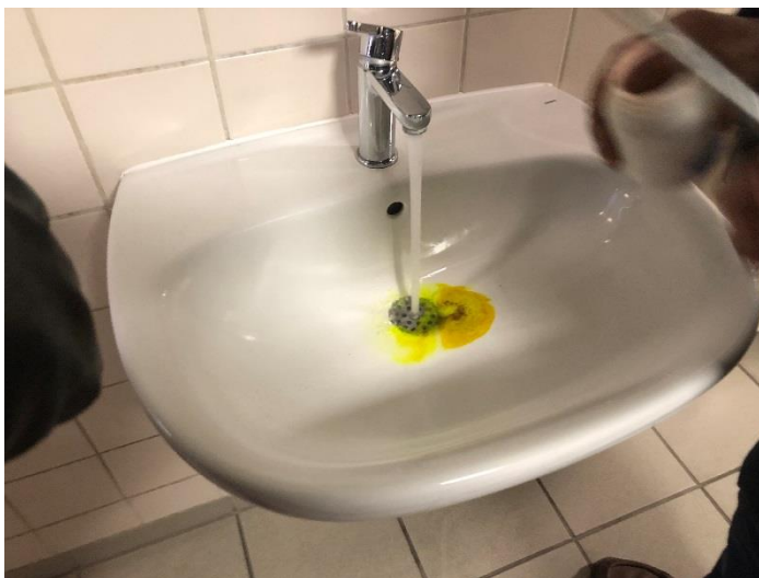
Contrôle au colorant
